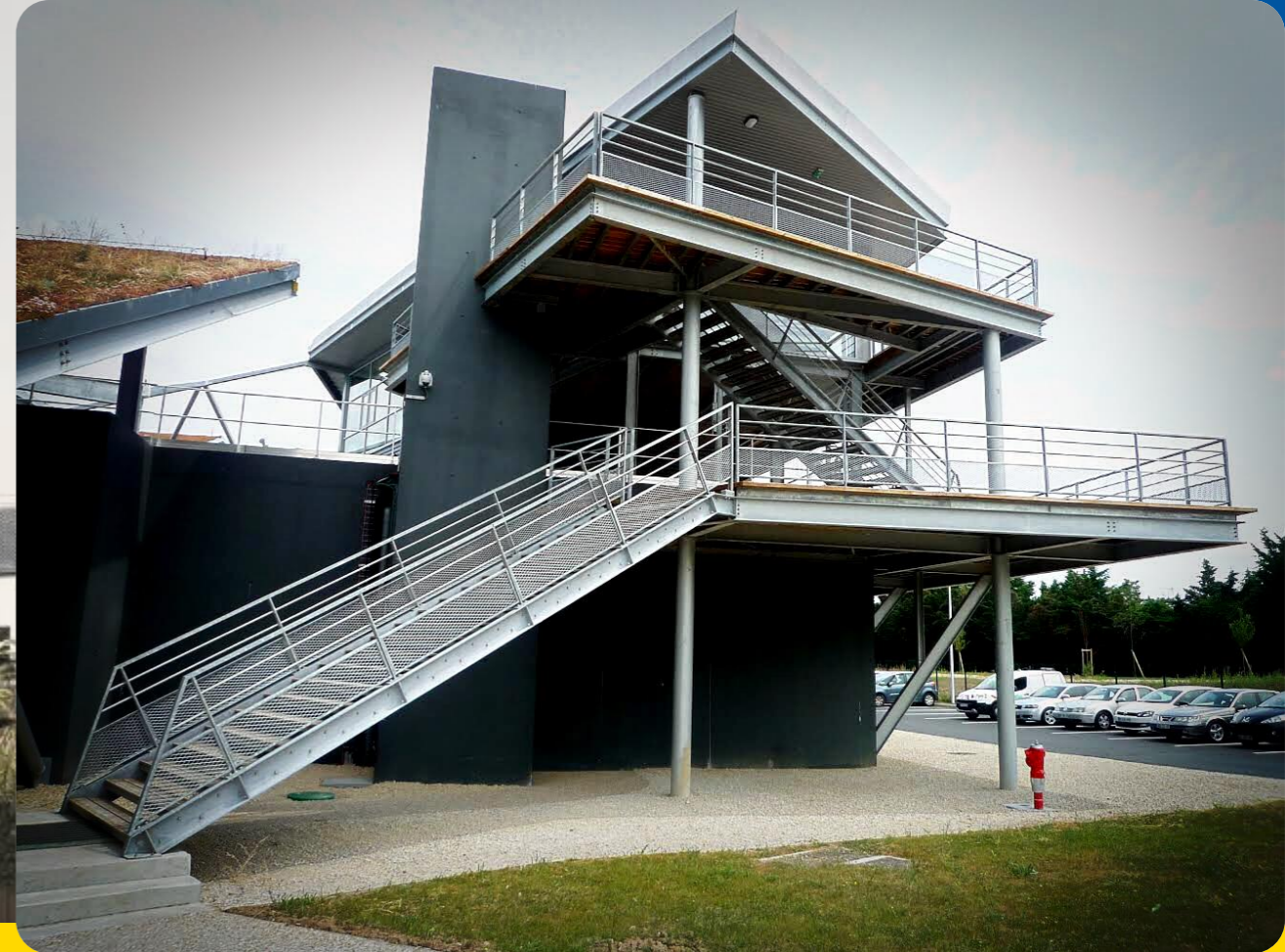
Station de traitement des eaux usées (L'Île d'Arrault_45)
